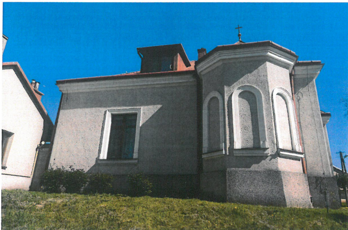
Fot. Nr 3. Budynek mieszkalny/przedszkole. Data powstania 1906-1910 r. Ul. Ks. Mazurkiewicza 34 Jasiień. Gmina Brzesko. Widok ogólny elewacji budynku od strony pięć/roczki Stan: przed konserwacją. Widoczne: dobudowana - zgodnie z projektem budynku absyda kaplicy z trzema „ślepyimi” oknami, po lewej widoczne zabudowania gospodarcze. Fot. Wojciech Siek . 05. 2022
