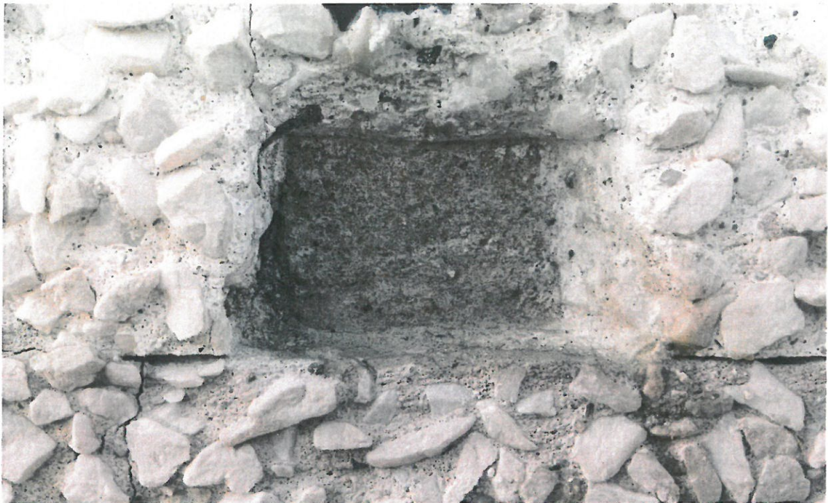
Fot. Nr 13. Budynek mieszkalny/przedszkole. Data powstania 1906-1910 r. Ul. Ks. Mazurkiewicza 34 Jasiień. Gmina Brzesko. Zbliżenie fragmentu gzymsu od strony Stan: przed konserwacją. Widoczne: odłonięty fragment oryginalnej warstwy tynkarskiej- wyraźnie ciemniejszej i drobnoziarnistej, pęknięcia , gruboziarnista wyprawa tynkarska z lat 90 tych XX w. Fot. Wojciech Siek . 05. 2022
