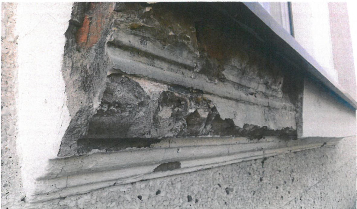
Fot. Nr 14. Budynek mieszkalny/przedszkole. Data powstania 1906-1910 r. Ul. Ks. Mazurkiewicza 34 Jasiień. Gmina Brzesko. Zbliżenie fragmentu gzymsu parapetowego od strony ptd/ksk Stan: przed konserwacją. Widoczne: odłonięty fragment oryginalnego profilowania stiukowego, liczne ubytki, rdzeń ceglany, gruboziarnista wyprawa tynkarska z lat 90 tych XX w. Fot. Wojciech Siek . 05. 2022
