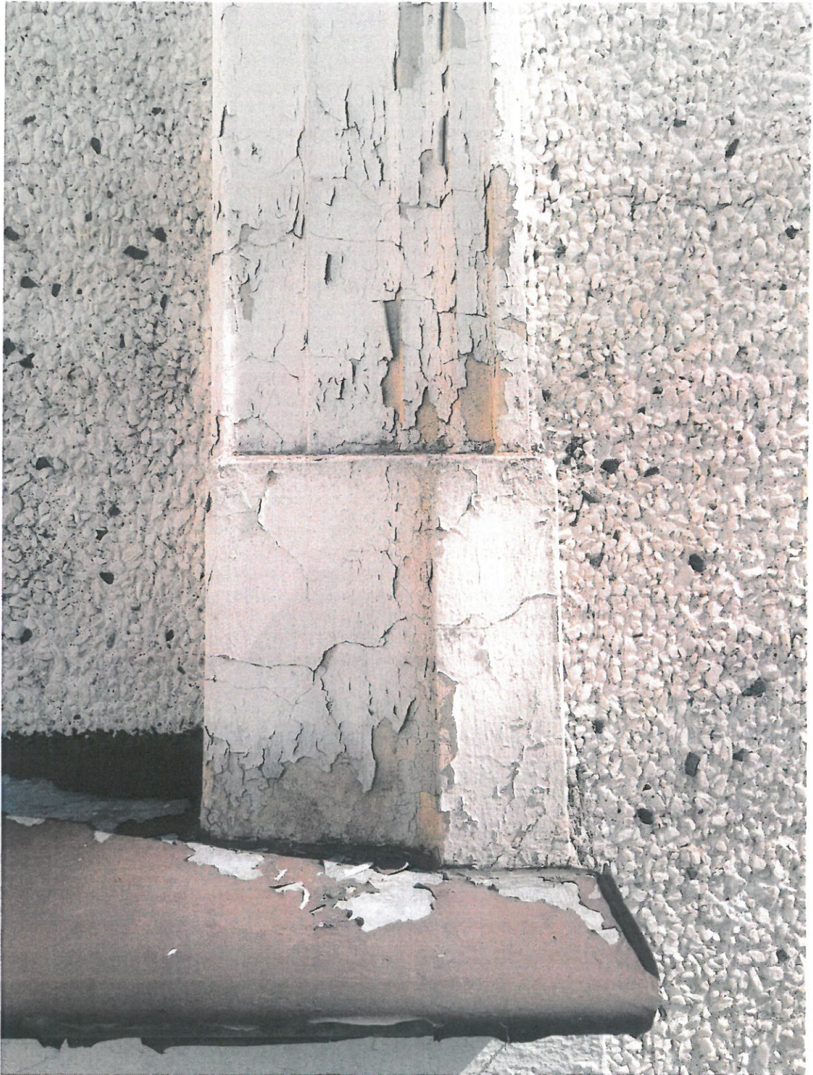
Fot. Nr 11. Budynek mieszkalny/przedszkole. Data powstania 1906-1910 r. Ul. Ks. Mazurkiewicza 34 Jasiień. Gmina Brzesko. Zbliżenie fragmentu fragmentu profilowanej opaski okiennej wykonanej ze stiuku. Stan: przed konserwacją. Widoczne: złuszczenia warstw farby elewacyjnej ujawniające oryginalną- różowawą kolorystykę stiuków, gruboziarnista wyprawa tynkarska z lat 90 tych XX w.
