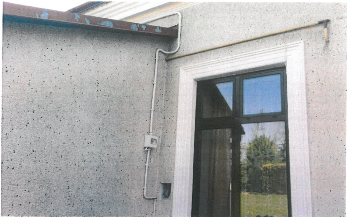
Fot. Nr 5. Budynek mieszkalny / przedszkole. Data powstania 1906-1910 r. Ul. Ks. Mazurkiewicza 34 Jasień. Gmina Brzesko. Widok ganku od strony pnw/wsch. Stan: przed konserwacją. Widoczne: dobudowany w późniejszym okresie ganek po lewej, widoczne instalacja gazowa i elektryczna, gruboziarnisty tynk z późniejszego okresu. Fot. Wojciech Siek . 05. 2022
