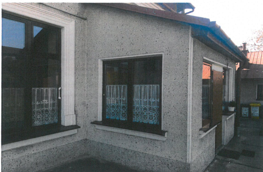
Fot. Nr 4. Budynek mieszkalny/przedszkole. Data powstania 1906-1910 r. Ul. Ks. Mazurkiewicza 34 Jasiień. Gmina Brzesko. Widok ganku od strony pięć/roczki Stan: przed konserwacją. Widoczne: dobudowany w późniejszym okresie ganek, po prawej widoczne zabudowania gospodarcze, gruboziarnisty tynk z późniejszego okresu. Fot. Wojciech Siek . 05. 2022
