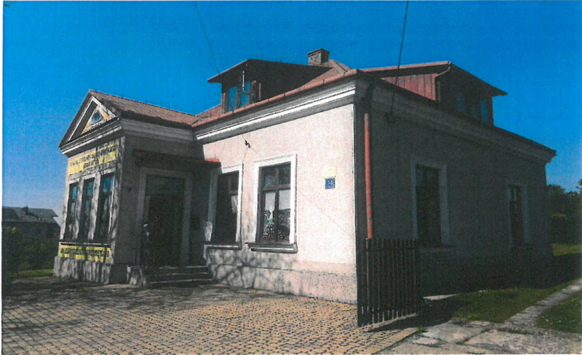
Fot. Nr 1. Budynek mieszkalny/przedszkole. Data powstania 1906-1910 r. Ul. Ks. Mazurkiewicza 34 Jasień. Gmina Brzesko. Widok ogólny elewacji frontowej i wschodniej budynku od strony pld./wsch. Stan: przed konserwacją. Fot. Wojciech Siek . 05. 2022
