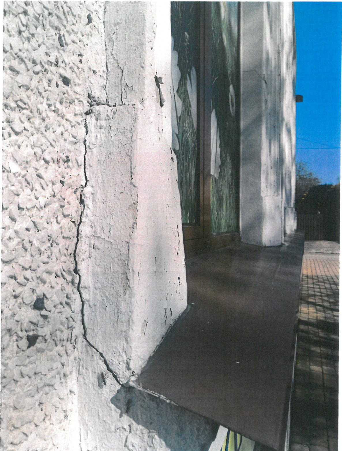
Fot. Nr 12. Budynek mieszkalny/przedszkole. Data powstania 1906-1910 r. Ul. Ks. Mazurkiewicza 34 Jasień. Gmina Brzesko. Zbliżenie fragmentu gzymsu od strony płec/wn. Stan: przed konserwacją. Widoczne: wzdłużne pęknięcie „stopy” profilowanej opaski okiennej, złuszczenia warstw farby elewacyjnej ujawniające oryginalną- różową kolorystykę stiuków, gruboziarnista wyprawa tynkarska z lat 90 tych XX w. Fot. Wojciech Siek . 05. 2022
