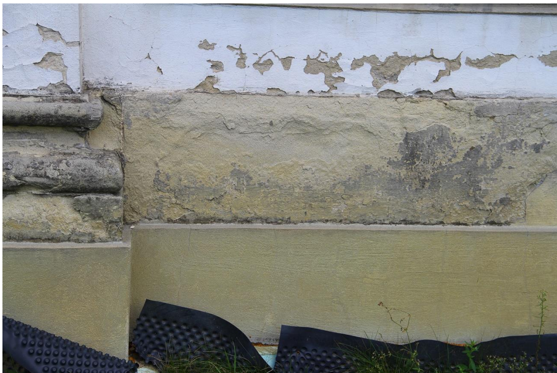
Fot. 18 kościół p.w. św Stanisława b.m. w Szczepanowie, gm. Brzesko. Fasada – destrukcja piaskowca w obrębie cokołu.
