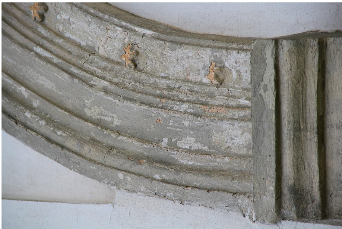
Fot. 12 kościół p.w. św Stanisława b.m. w Szczepanowie, gm. Brzesko. Fasada – nawarstwienia wtórne na powierzchni kamiennego łuku nad wejściem głównym.
