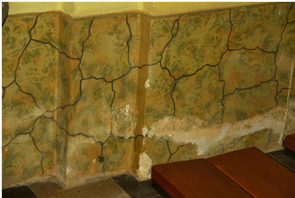
Fot. 38 kościół p.w. św Stanisława b.m. w Szczepanowie, gm. Brzesko. Wnętrze kościoła, fragment – silna erozja warstwy tynkowej, spowodowana zasoleniem muru w przyziemiu ściny północnej.
