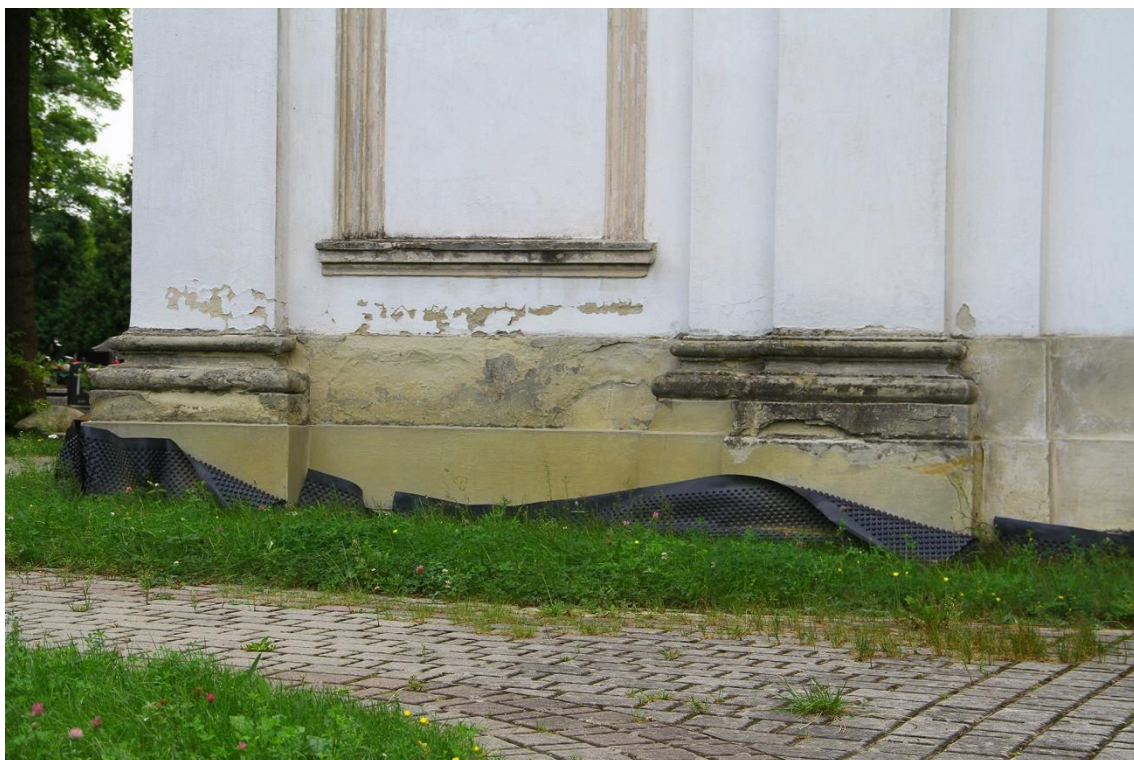
Fot. 17 kościół p.w. św Stanisława b.m. w Szczepanowie, gm. Brzesko. Fasada – fragment cokołu z widoczną silną erozją kamienia, spowodowaną zawilgoceniem i zasoleniem.
