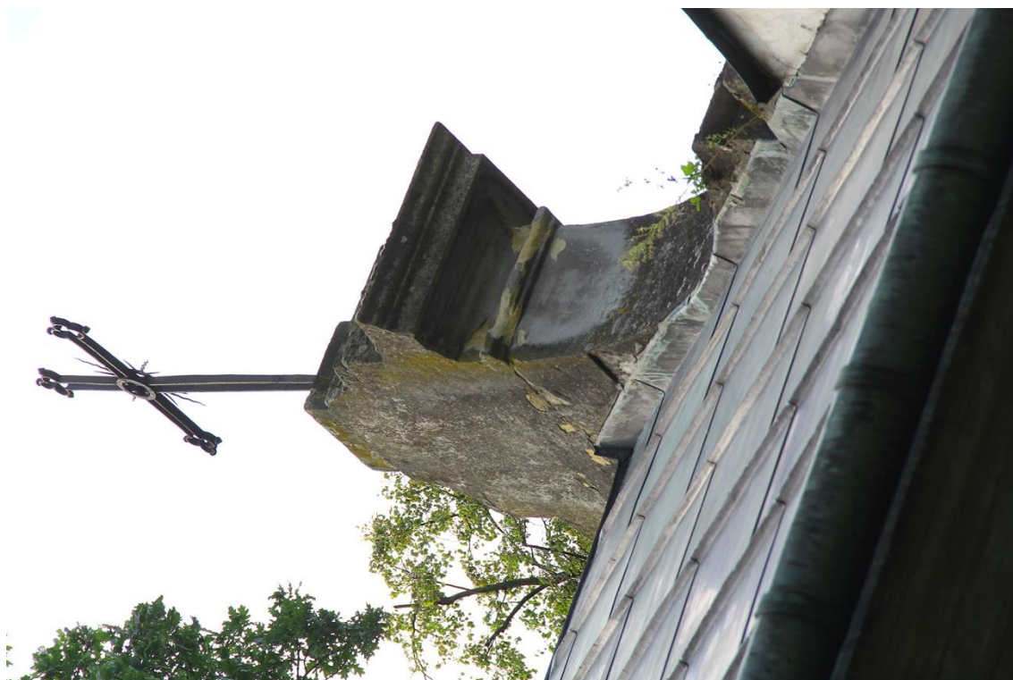
Fot. 25 kościół p.w. św Stanisława b.m. w Szczepanowie, gm. Brzesko... Zwieńczenie attyki elewacji frontowej, widoczne od tyłu, z silnymi zakwitami mchu.
