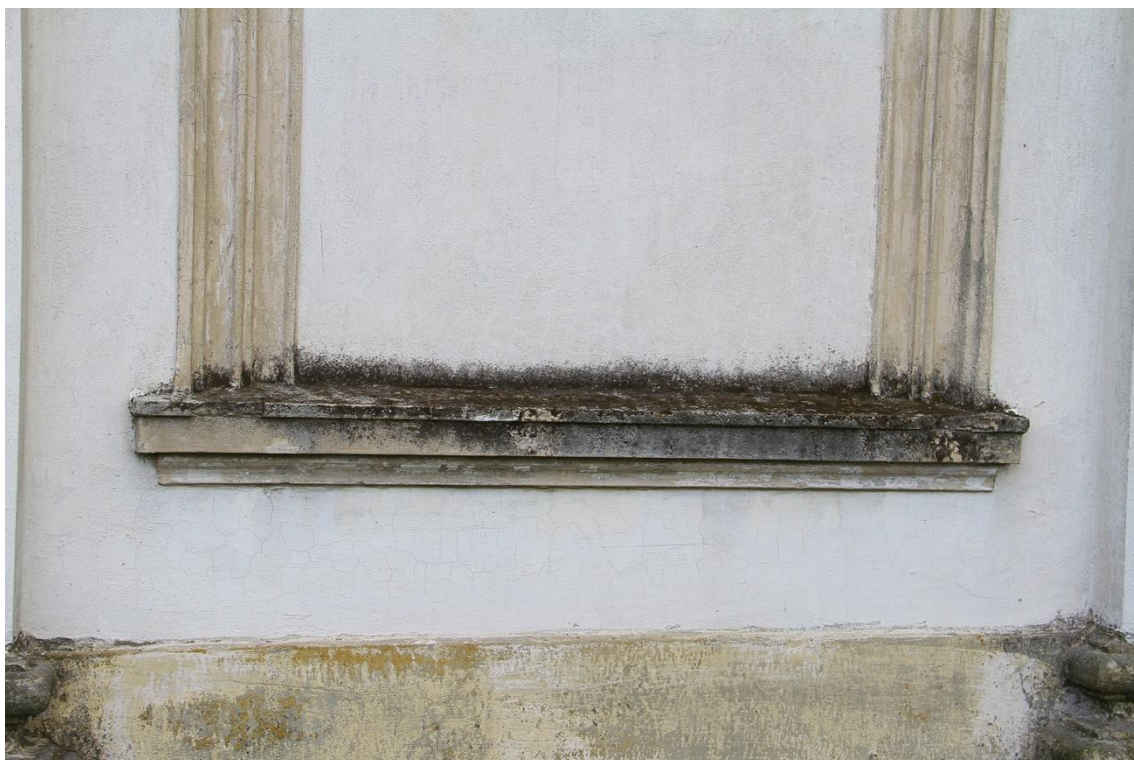
Fot. 16 kościół p.w. św Stanisława b.m. w Szczepanowie, gm. Brzesko. Fasada, fragment – gzymsowanie płyciny z widocznymi silnymi zakwitami glonów i mchów.
