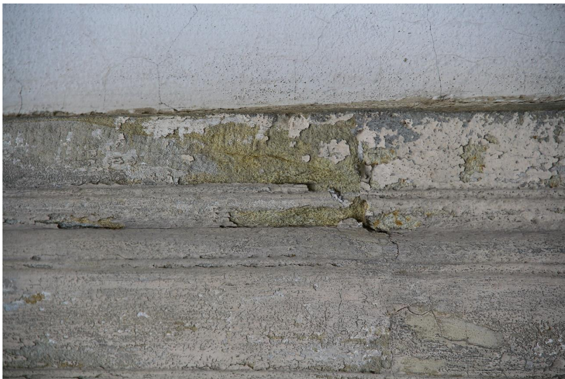
Fot. 14 kościół p.w. św Stanisława b.m. w Szczepanowie, gm. Brzesko. Fasada, fragment – sły stan zacowania piaskowca pod warstwami wtórnymi, widoczny w ich ubytku.
