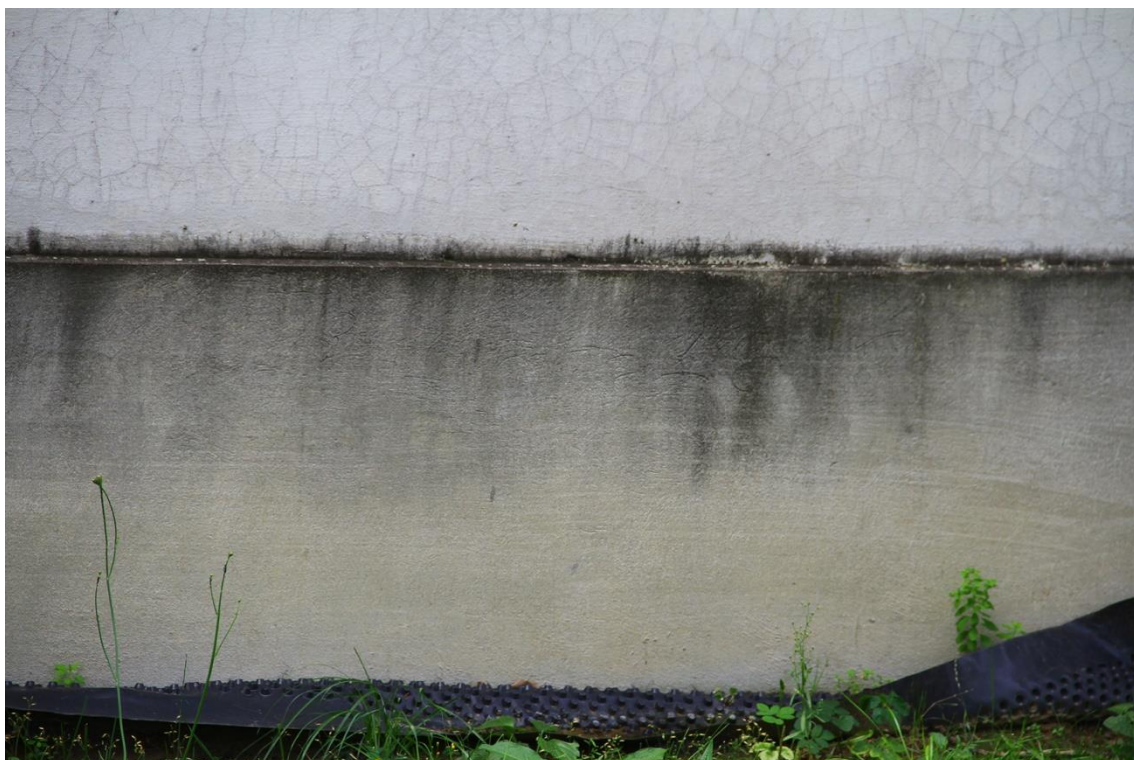
Fot. 28 kościół p.w. św Stanisława b.m. w Szczepanowie, gm. Brzesko. Fragment cokołu elewacji wschodniej z widocznym zagłoniem powierzchni.
