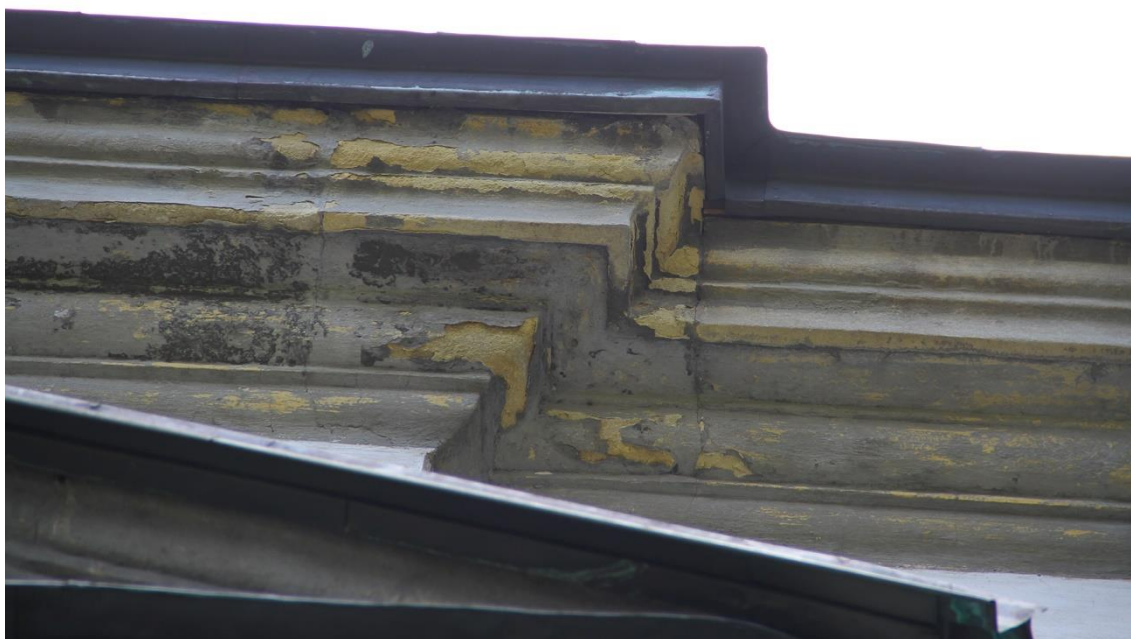
Fot. 7 kościół p.w. św Stanisława b.m. w Szczepanowie, gm. Brzesko. Fasada – fragment gzymsu wieńczącego z widocznymi wtórnymi nawarstwieniami.
