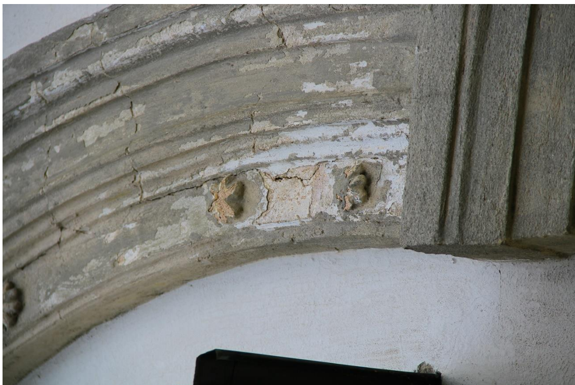
Fot. 13 kościół p.w. św Stanisława b.m. w Szczepanowie, gm. Brzesko. Fasada – nawarstwienia wtórne na powierzchni łuku kamiennego nad wejściem głównym.
