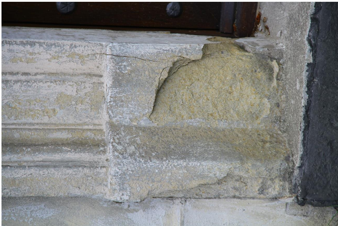
Fot. 15 kościół p.w. św Stanisława b.m. w Szczepanowie, gm. Brzesko. Fasada, fragment – ubytek kamienia spowodowany procesami erozyjnymi.
