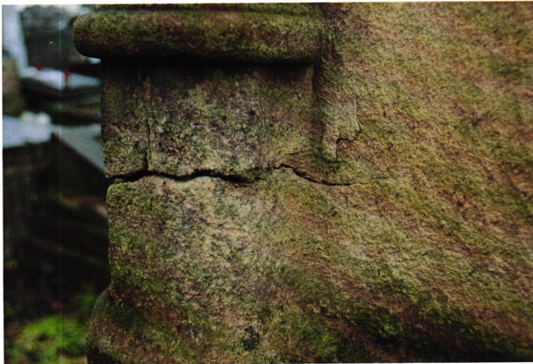
Fot. Nr 24. Cmentarz parafialny w Brzesku dat. na 1815 r. Gmina Brzesko. Zbliżenie konsoli cokołu kamiennego nagrobka Franciszka Lisaka z 1909 r. Stan: przed konserwacją. Widoczne: ubytki formy detali architektonicznych, poprzeczne pęknięcie, zabrudzenia atmosferyczne, fałszywa patyna. Fot. Wojciech Siek 10. 2023 r.
