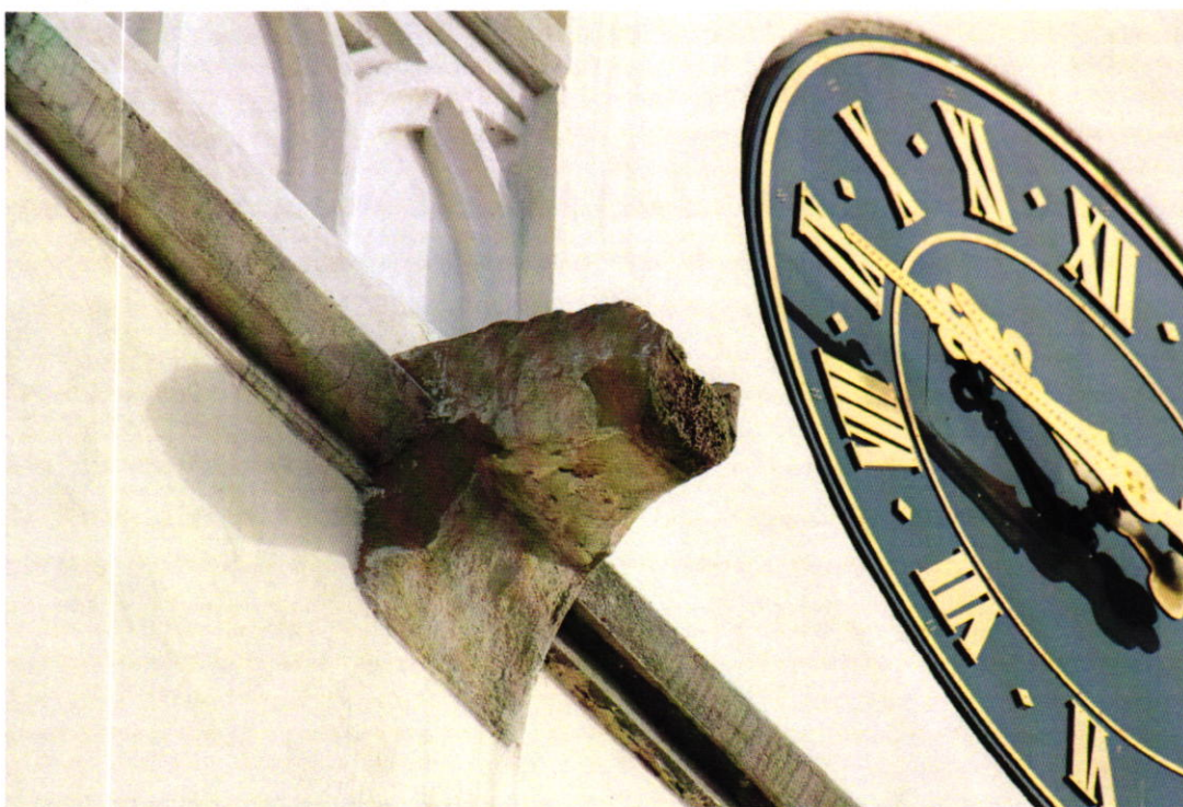
Fot. Nr 10. Gotycki kościół pw. św. Jakuba w Brzesku dat. na 1447 r. Zbliżenie kamiennego rzygacza. Stan: przed konserwacją. Widoczne: przebarwienia i ubytki kamienia- rozmyty i zdeintegrowany kształt elementu . Fot. Wojciech Siek 04.2024 r.
