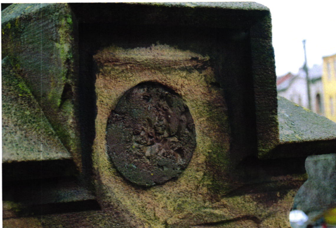
Fot. Nr 29. Cmentarz parafialny w Brzesku dat. na 1815 r. Gmina Brzesko. Zbliżenie górnej części kamiennego nagrobka rodziny Kubasiewiczów dat. Na 1873 r. Stan: przed konserwacją. Widoczne: brak medalionowej płaskorzeźby kobiecej, ubytki, zabrudzenia, mchy i porosty, fałszywa patyna. Fot. Wojciech Siek 10. 2023 r.
