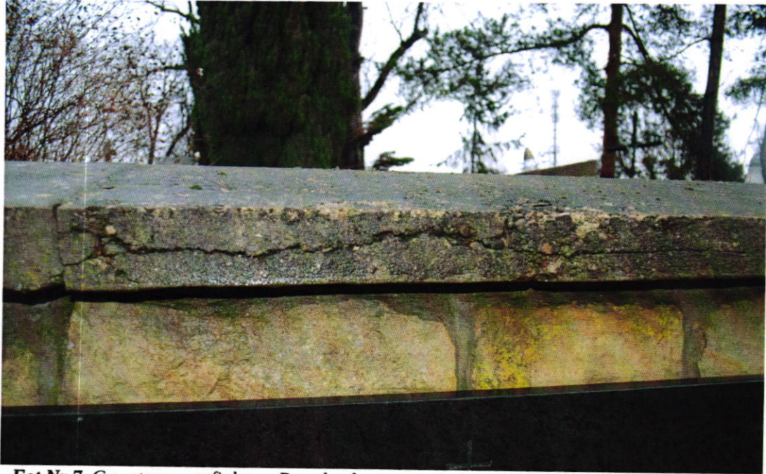
Fot Nr 7. Cmentarz parafialny w Brzesku dat. na 1815 r. Gmina Brzesko. Zbliżenie fragmentu betonowej nakrywy muru. Stan: przed konserwacją. Widoczne: rozległe wzdłużne pęknięcia, zabrudzenia, fałszywa patyna, kolonie mikroorganizmów. Fot. Wojciech Siek 10. 2023 r.
