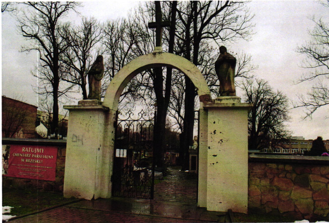
Fot Nr 1. Cmentarz parafialny w Brzesku dat. na 1815 r. Gmina Brzesko. Ujęcie bramy cmentarza od str. płd. Stan: przed konserwacją. Widoczne: złuszczające się nawarstwienia farb, spękania, ubytki, zabrudzenia, fałszywa patyna, rozmyte detale rzeźbiarskie figur. Fot. Wojciech Siek 10. 2023 r.
