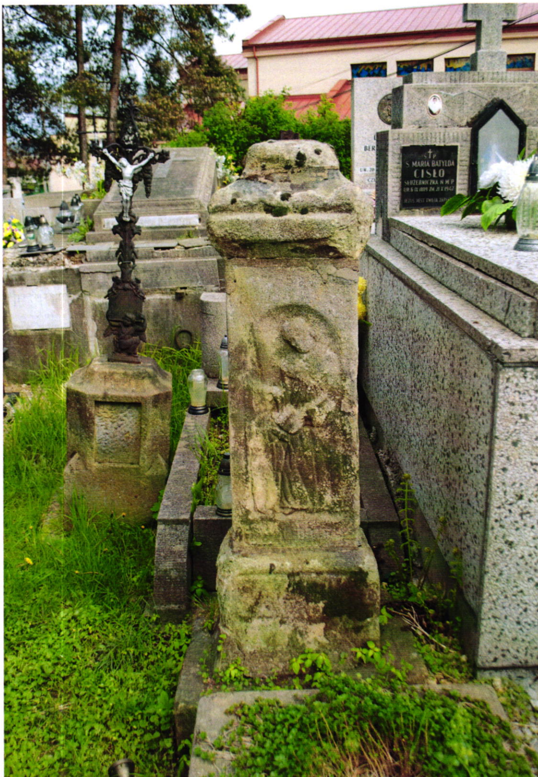
Fot Nr 15. Cmentarz parafialny w Brzesku dat. na 1815 r. Gmina Brzesko. Ujęcie ogólne kamiennego nagrobka nieznanego proboszcza parafii z I poł. XIX w. Stan: przed konserwacją. Widoczne: silne rozmycie formy architektonicznej cokołu i elementów płaskorzeźbionych, mchy i porosty, fałszywa patyna, utracony żeliwny krzyż. Fot. Wojciech Siek 10. 2023 r.
