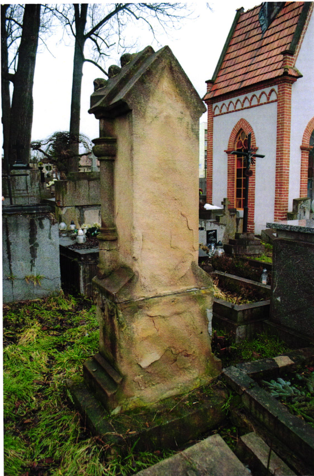
Fot. Nr 21. Cmentarz parafialny w Brzesku dat. na 1815 r. Gmina Brzesko. Ujęcie ogólne od str. wsch. kamiennego nagrobka Franciszka Lisaka z 1909 r. Stan: przed konserwacją. Widoczne: uszkodzenia i ubytki formy architektonicznej nagrobka i elementów rzeźbionych, mchy i porosty, fałszywa patyna, roślinność. Fot. Wojciech Siek 10. 2023 r.
