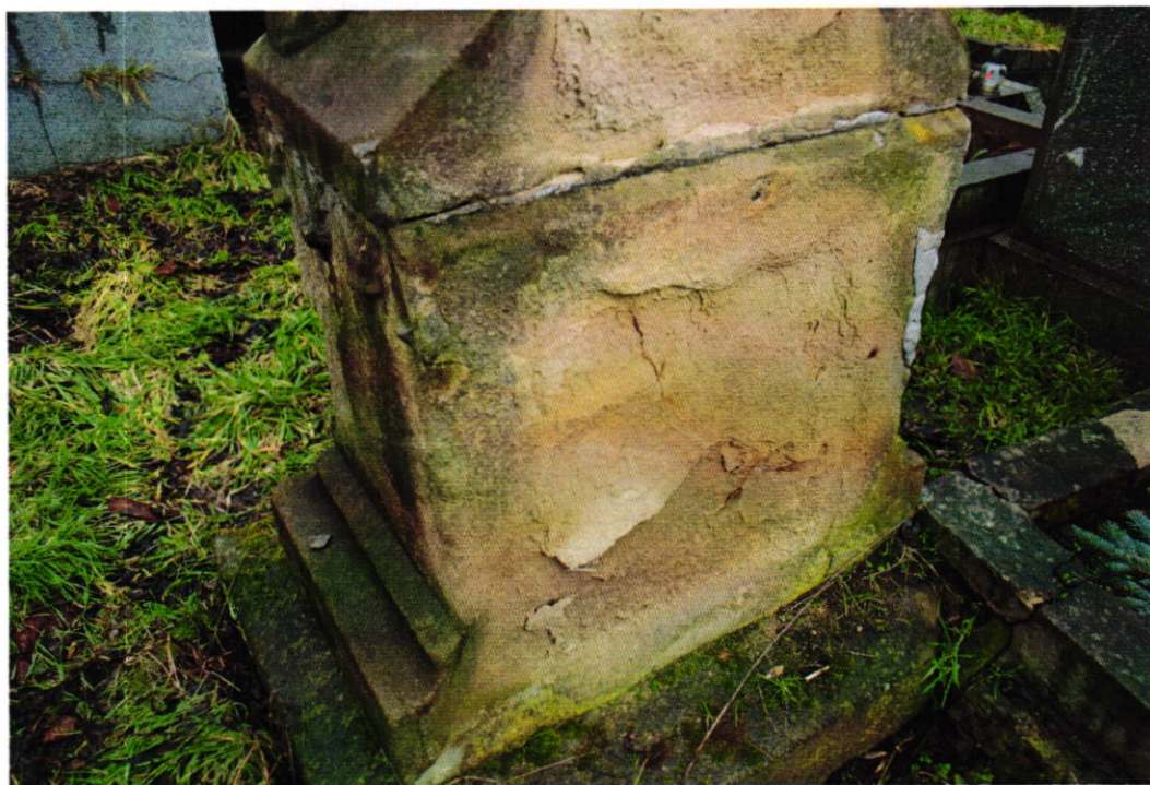
Fot. Nr 23. Cmentarz parafialny w Brzesku dat. na 1815 r. Gmina Brzesko. Zbliżenie dolnej części cokołu kamiennego nagrobka Franciszka Lisaka z 1909 r. Stan: przed konserwacją. Widoczne: ubytki formy detali architektonicznych nagrobka, nadlany fragment sąsiadującego, betonowego nagrobka, mchy i porosty, fałszywa patyna. Fot. Wojciech Siek 10. 2023 r.
