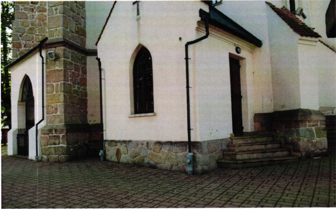
Fot. Nr 1. Gotycki kościół pw. św. Jakuba w Brzesku dat. na 1447 r. Ujęcie dolnej partii elewacji od str. płn./wsch. Stan: przed konserwacją. Widoczne: nawarstwienia ciemnej patyny na powierzchni kamiennej podmurówki, zawilgocenie-kolonie mikroorganizmów, kostka brukowa przylegająca do kamiennej podmurówki. Fot. Wojciech Siek 04.2024 r.
