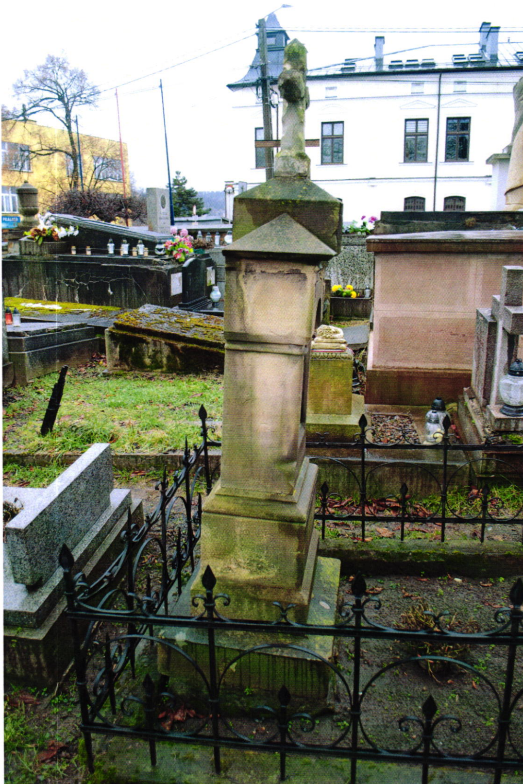
Fot. Nr 27. Cmentarz parafialny w Brzesku dat. na 1815 r. Gmina Brzesko. Ujęcie od str. płu. kamiennego nagrobka rodziny Kubasiewiczów dat. Na 1873 r. Stan: przed konserwacją. Widoczne: silne przechylenie obiektu w str. zachodnią, mchy i porosty, fałszywa patyna, ubytki betonowego obramienia.
