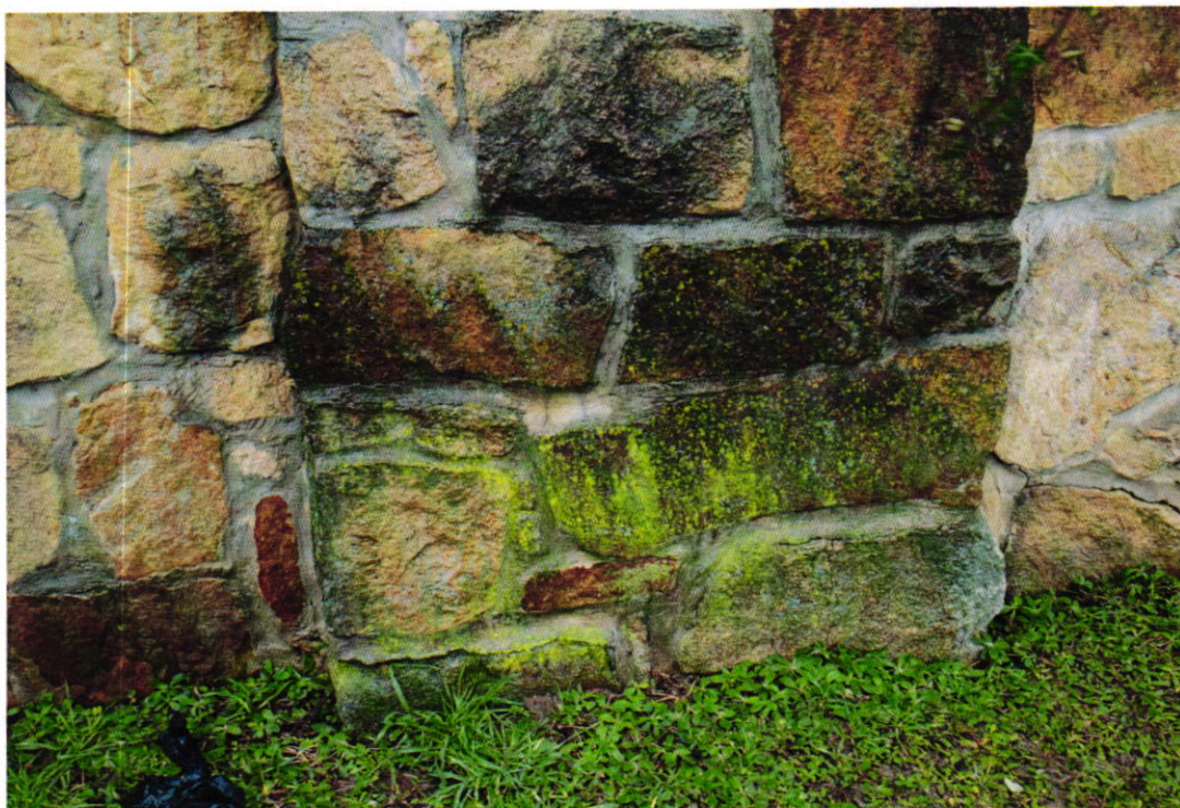
Fot Nr 3. Cmentarz parafialny w Brzesku dat. na 1815 r. Gmina Brzesko. Zbliżenie fragmentu płd. części muru cmentarza. Stan: przed konserwacją. Widoczne: zabrudzenia, fałszywa patyna, kolonie mikroorganizmów. Fot. Wojciech Siek 10. 2023 r.
