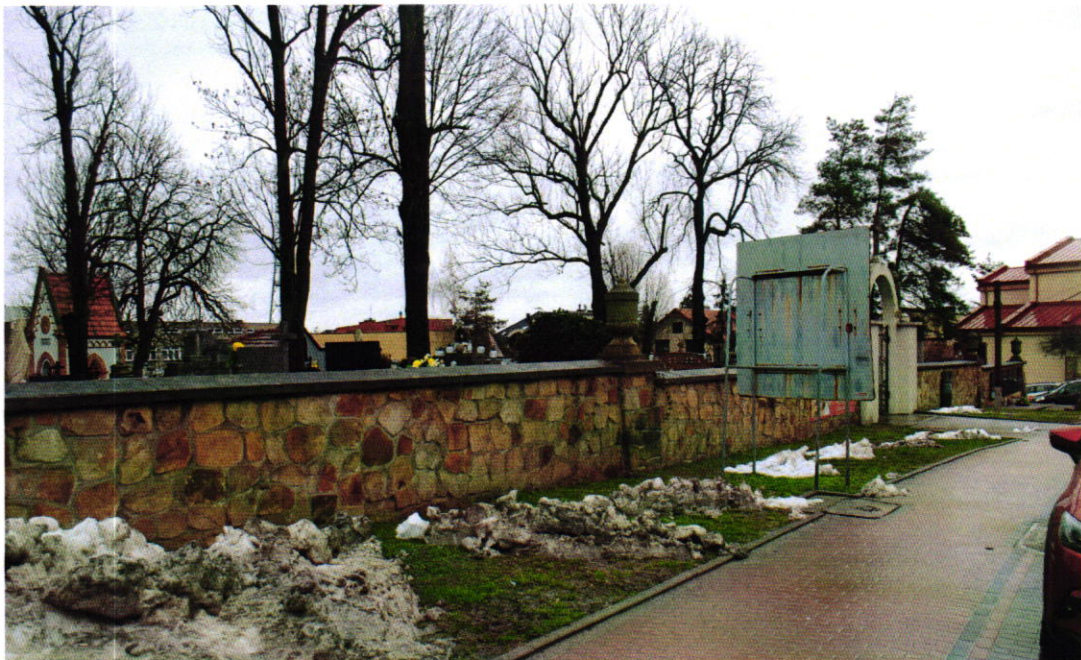
Fot Nr 2. Cmentarz parafialny w Brzesku dat. na 1815 r. Gmina Brzesko. Ujęcie płd. części kamiennego muru cmentarza od str. płd/zach. Stan: przed konserwacją. Widoczne: zabrudzenia, fałszywa patyna. Fot. Wojciech Siek 10. 2023 r.
