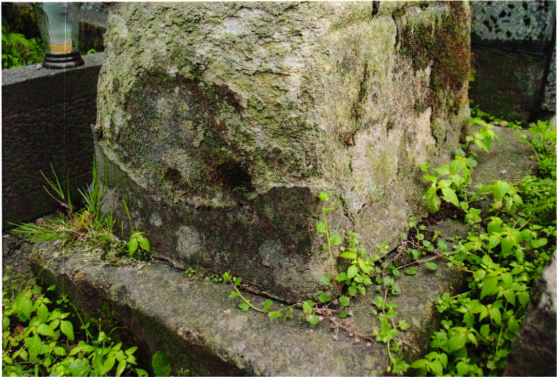
Fot Nr 18. Cmentarz parafialny w Brzesku dat. na 1815 r. Gmina Brzesko. Zbliżenie podstawy cokołu kamiennego nagrobka nieznanego proboszcza parafii z I poł. XIX w. Stan: przed konserwacją. Widoczne: silne rozmycie formy architektonicznej elementów cokołu, uzupełnienia wykonane z zaprawy cementowej, mchy i porosty, fałszywa patyna, roślinność. Fot. Wojciech Siek 10. 2023 r.
