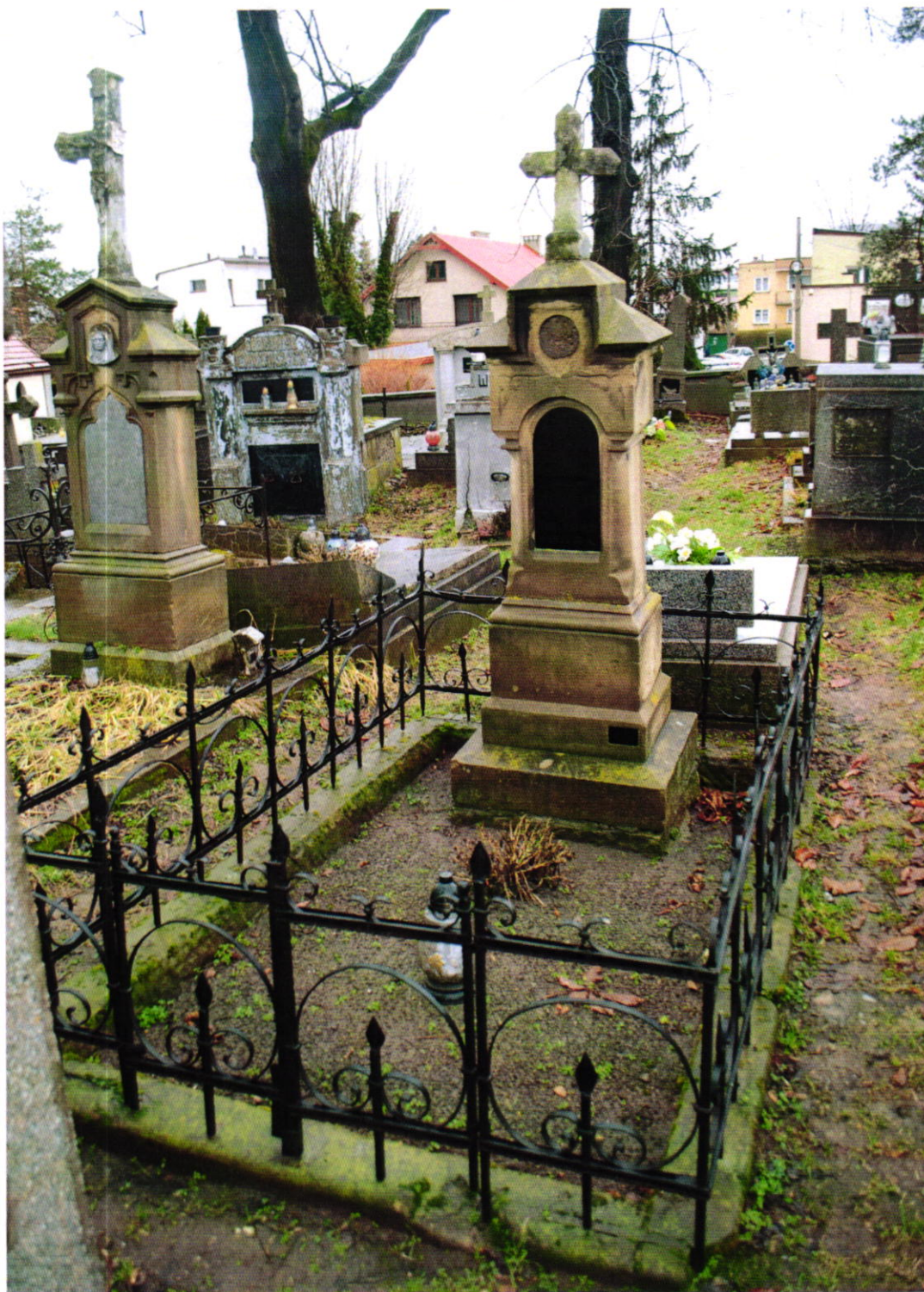
Fot. Nr 26. Cmentarz parafialny w Brzesku dat. na 1815 r. Gmina Brzesko. Ujęcie frontalne kamiennego nagrobka rodziny Kubasiewiczów dat. Na 1873 r. Stan: przed konserwacją. Widoczne: uszkodzenia formy architektonicznej nagrobka, brak elementów rzeźbionych- popiersie, mchy i porosty, fałszywa patyna, ubytki betonowego obramienia. Fot. Wojciech Siek 10. 2023 r.
